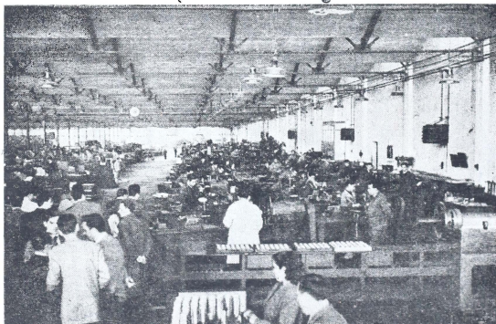
Naves de la fábrica de Getafe, donde se construyen piezas en serie del nuevo avión español "Alcotán".
