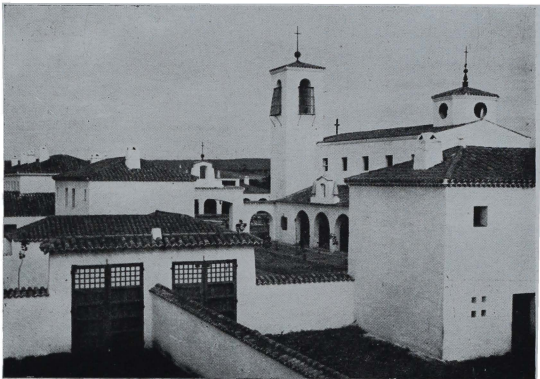
Estas casas para labradores de la provincia de Salamanca (Águeda del Caudillo) fueron entregadas a sus propietarios el pasado Setiembre. Son el resultado de una experiencia arquitectónica centenaria y excluye modernismos caros que quedarán viejos en 1960. Son los que tienen que ser porque respetan la arquitectura campesina regional, que en España cambia a cada kilómetro.
