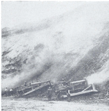
Para recuperar piezas de hierro cuyo peso varía de unas cuantas libras a mil, se están empleando "bulldozers" en los montones de escoria de la fábrica de Minnequa, de la "Fuel and Iron Corporation"—Corporación de Combustible y Hierro—, de Pueblo, Colorado, en el oeste de Estados Unidos. Este metal que se recupera sirve para mantener el alto grado de producción de acero de los Estados Unidos, al objeto de responder a la gran demanda nacional y extranjera de acero y sus manufacturas. Se calcula que se emplearán 25 años para recuperar todo el hierro que hay en este montón que tiene seis millas de longitud.
