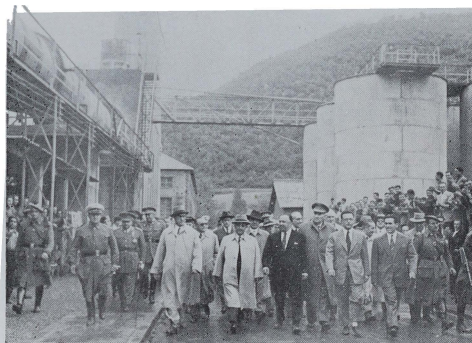
Fábrica de Cemento de Xerralló. Para una capacidad de fabricación del orden de 250 Tn diarias.
