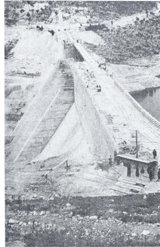
Una vista del estado actual de las obras del Pantano de Alarcón, con capacidad para 700 millones de metros cúbicos y al cual sólo faltan los últimos toques para su terminación.—Foto CIFRA GRAFICA
