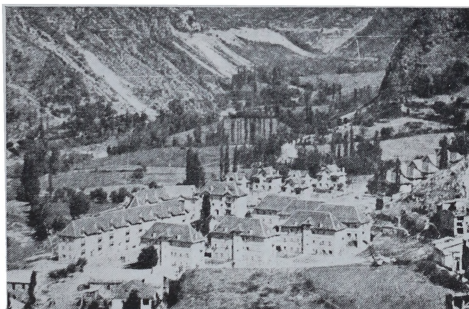
Oficinas centrales de la Empresa en Pont de Suert.
