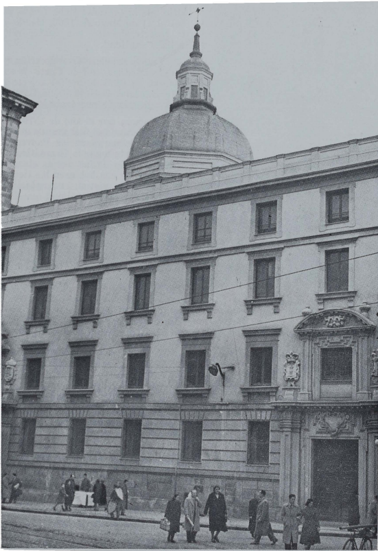
Fachada actual del Instituto de San Isidro, en la Calle de Toledo a la entrada de la Calle de los Estudios, en el lugar que ocupó el antiguo "Estudio de Madrid".
