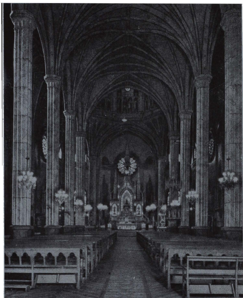
Nave Central de la Basílica.
