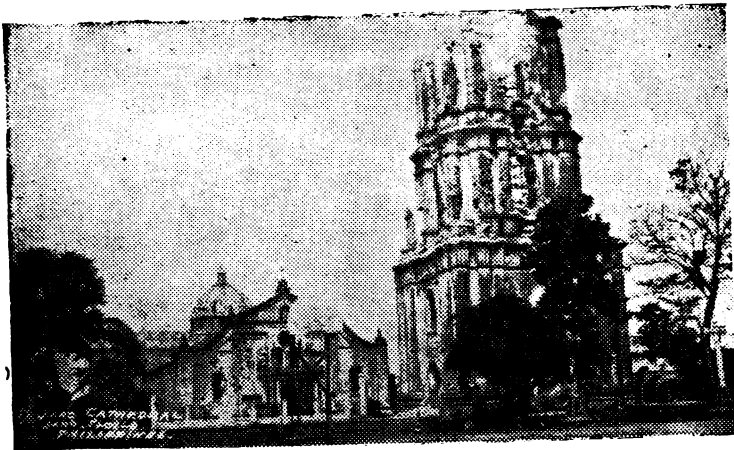
Catedral de Jaro con su torre dañada por los temblores.
