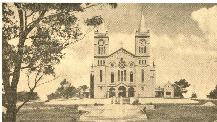
Baguio, Catedral de la Ntra. Señora de la Reparación.
