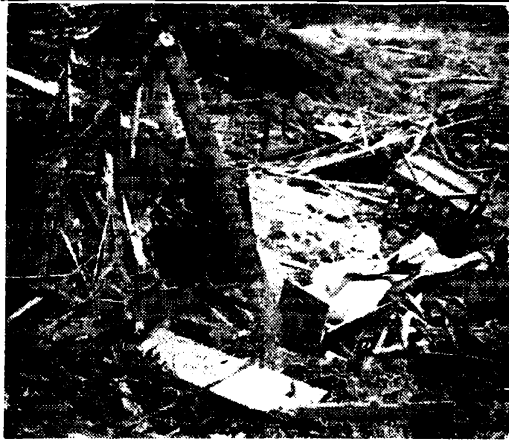
La acción de una bomba americana esta descrita en esta fotografía que capta los escombros del que fue feliz hogar de una familia filipina de Davao. Esta casa figura entre las residencias de propiedad filipina y ocupadas por filipinos que fueron destruidas por los aviones de bombardeo americanos en sus recientes raids.
