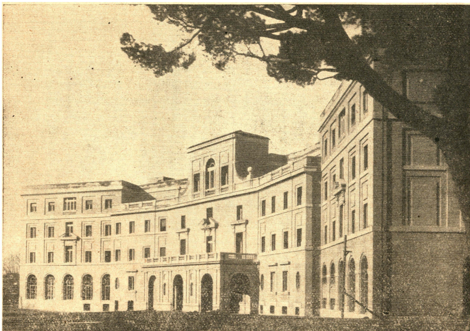
Fachada del Nuevo Colegio de la Propaganda
