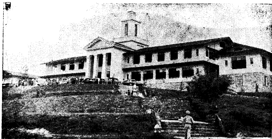
El nuevo Ayuntamiento (City Hall) de la ciudad de Baguio, cuya inauguración se llevó a cabo recientemente. Fue bendecido por el Vicario Apostólico de la Montañosa, Mons. William Brasser.
